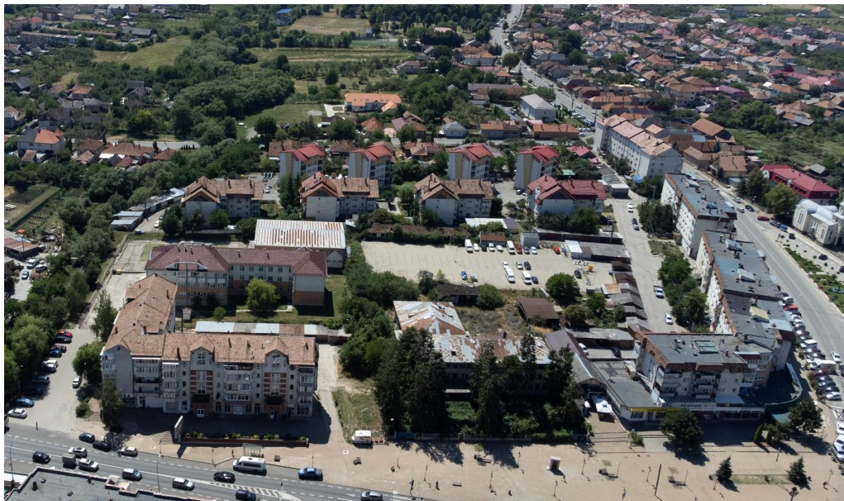
Fig. 109 Construcția de blocuri în zona centrală a orașului Huedin (Piața Republicii nr. 39-42, nr. 44-48, Aleea 1 Mai și Strada Avram Iancu nr. 1 și 3)
