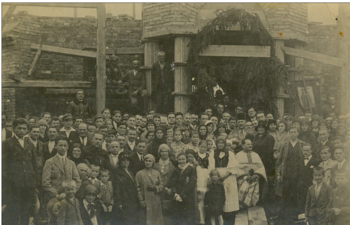
Fig. 75 „Catedrala Moților” din Huedin în construcție
