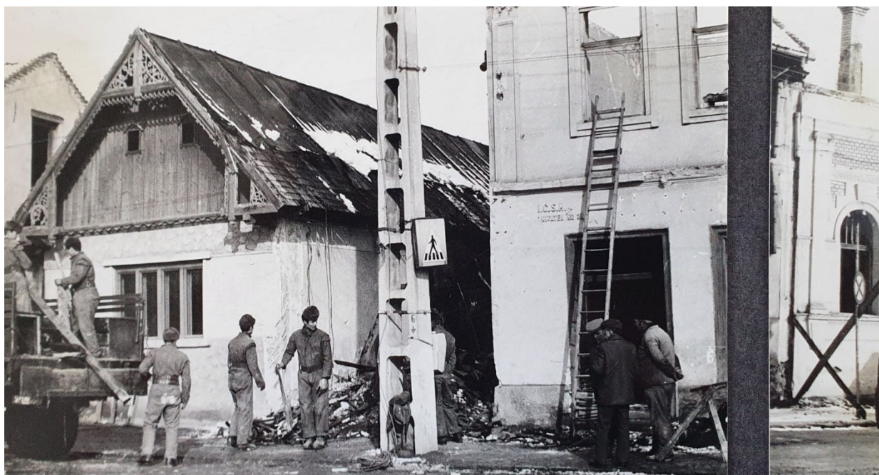
Fig. 107 Demolări de case în zona centrală a orașului Huedin
