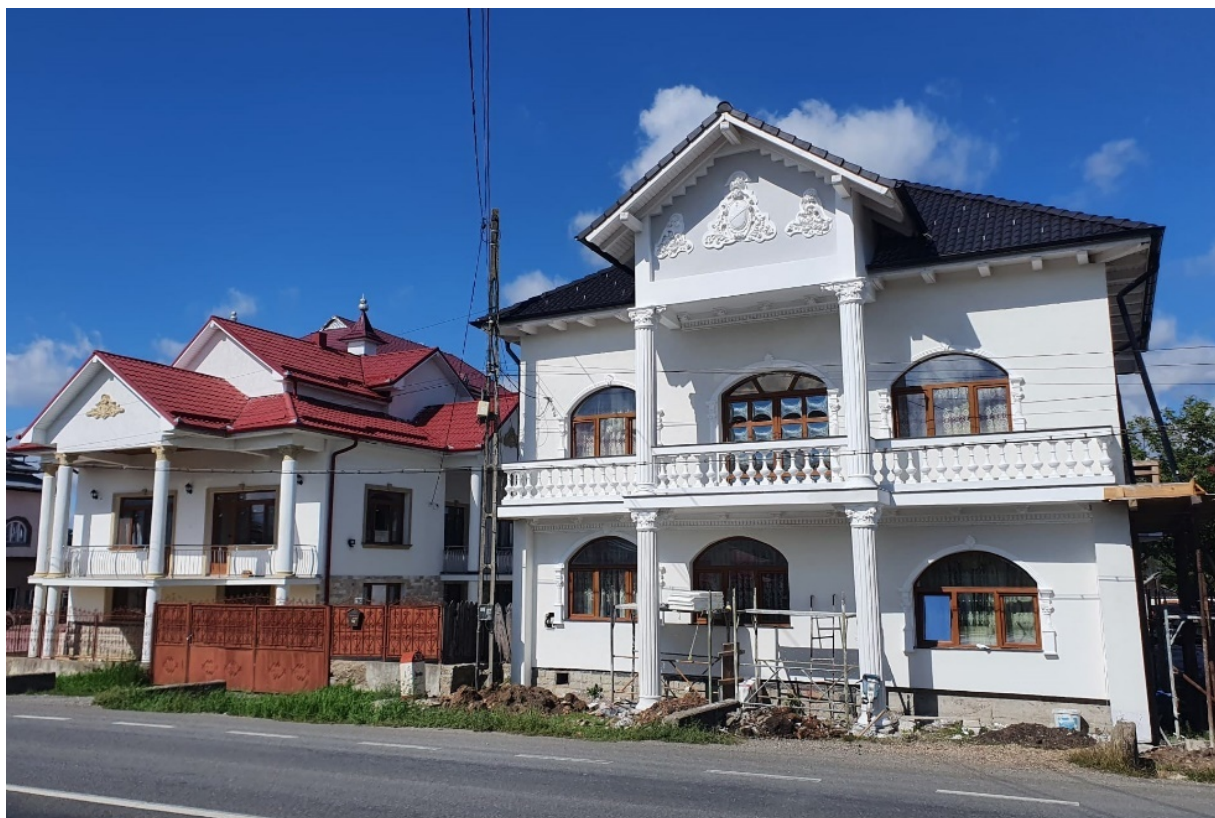
Fig. 57 Alte construcții ale rromilor fără acoperișuri în trepte și fără turnulețe
