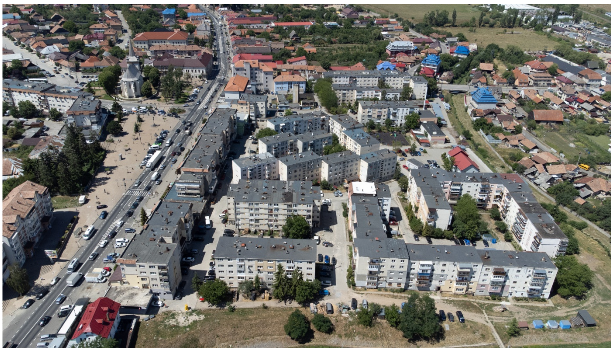
Fig. 108 Construcţia de blocuri în zona centrală a oraşului Huedin (Piaţa Republicii nr. 8 şi strada Vlădeasa)
